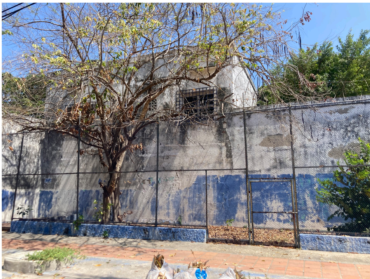
Vista del predio desde un lateral, apreciándose el muro y valla y otras medidas de seguridad.
